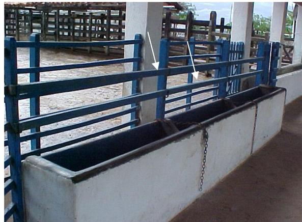
**Figura 7.** Ripões removíveis que separam os módulos 2 e 3.
