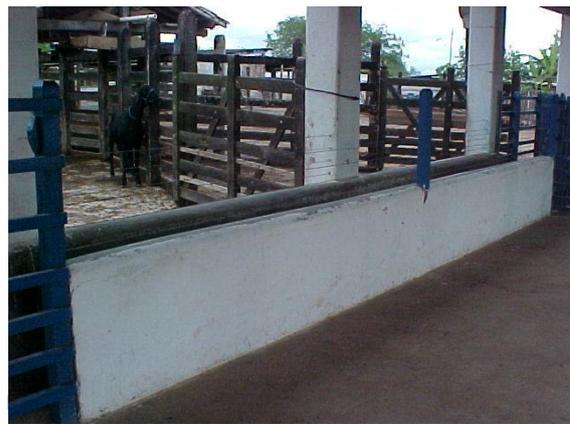
A parte final do módulo 4 é fechada por um portão de 0,57m de largura e 1,24m de altura, que se abre para o módulo seguinte. (Figura 23).
