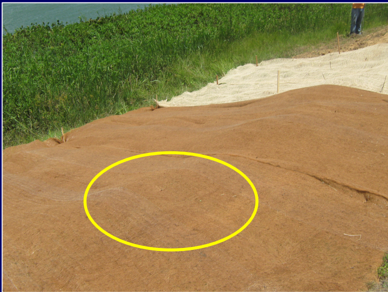
FIGURA 4: geotêxtil instalado no talude do rio (15/11/08)
