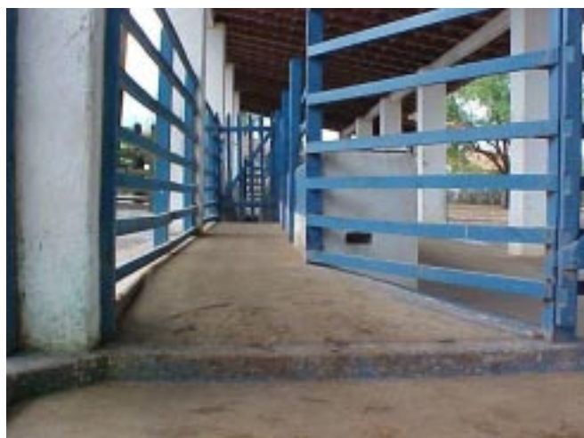
Figura 5. Rampa de acesso ao módulo 2.
